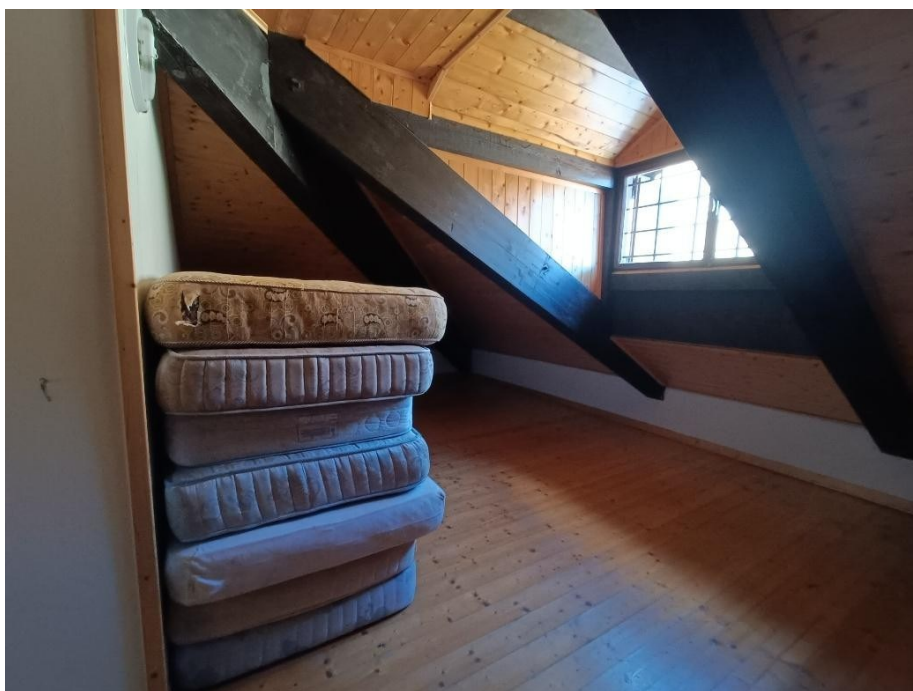
Foto 36 – MALGA TASSULLA – SOFFITTA – STANZA 3. Foto di data 29.10.2025
