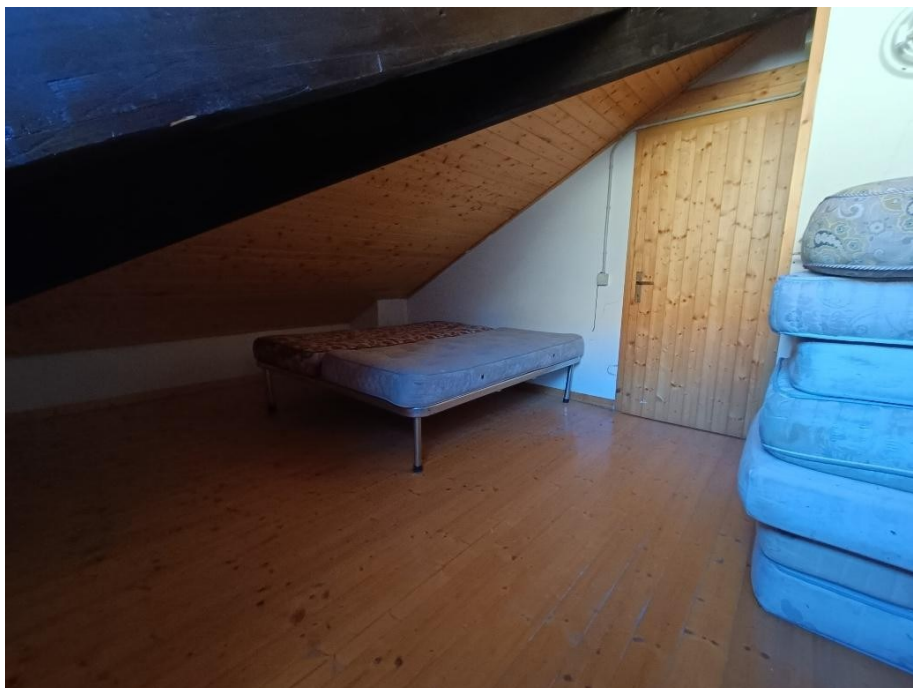
Foto 35 – MALGA TASSULLA – SOFFITTA – STANZA 3. Foto di data 29.10.2025
