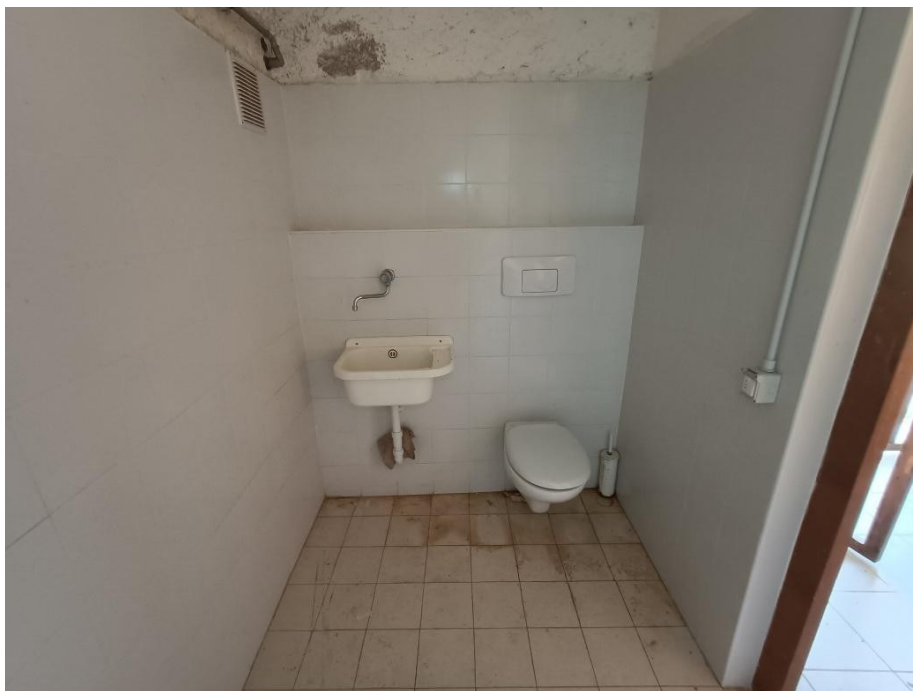
Foto 53 – STALLONE – BAGNO A SERVIZIO DEL BIVACCO. Foto di data 29.10.2025
