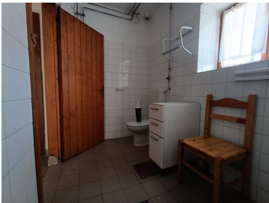
Foto 10 – MALGA TASSULLA – LOCALE BAGNO A SERVIZIO DEL CASEIFICIO. Foto di data 29.10.2025
