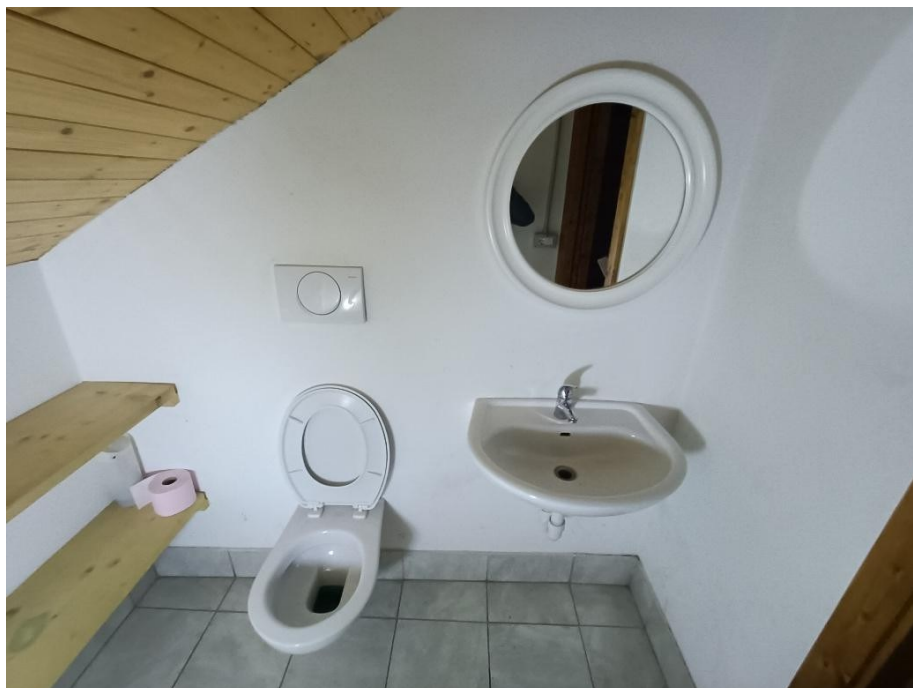
Foto 29 – MALGA TASSULLA – SOFFITTA – BAGNO A SERVIZIO DELLE STANZE. Foto di data 29.10.2025
