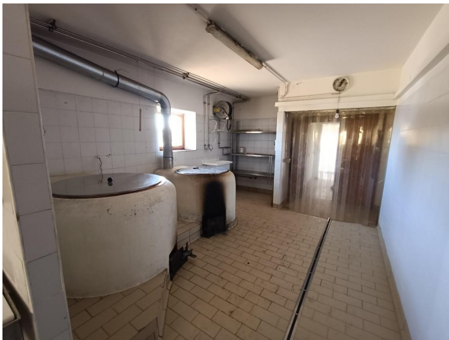
Foto 19 – MALGA TASSULLA – LOCALE CASEIFICIO – COTTURA. Foto di data 29.10.2025
