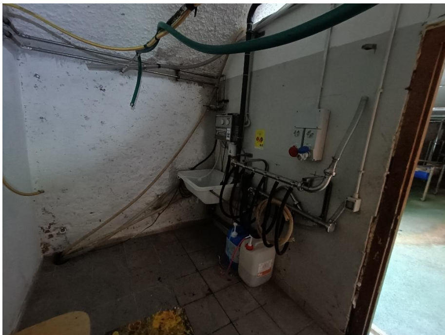
Foto 49 – STALLONE – LOCALE IMPIANTO DI LAVAGGIO MUNGITURA. Foto di data 29.10.2025
