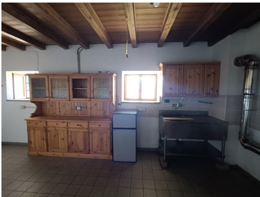
Foto 26 – MALGA TASSULLA – LOCALE CUCINA. Foto di data 29.10.2025
