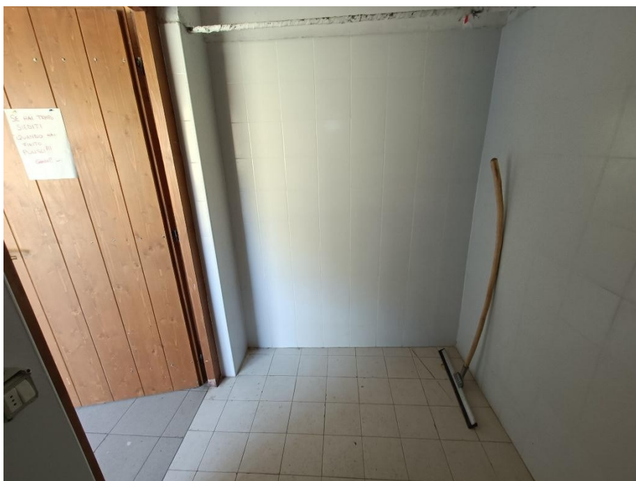
Foto 54 – STALLONE – BAGNO A SERVIZIO DEL BIVACCO. Foto di data 29.10.2025
