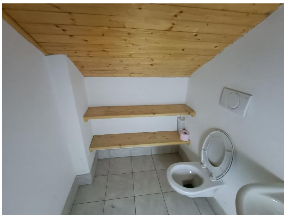
Foto 30 – MALGA TASSULLA – SOFFITTA – BAGNO A SERVIZIO DELLE STANZE. Foto di data 29.10.2025
