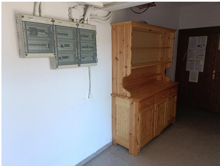
Foto 7 – MALGA TASSULLA – LOCALE INGRESSO. Foto di data 29.10.2025
