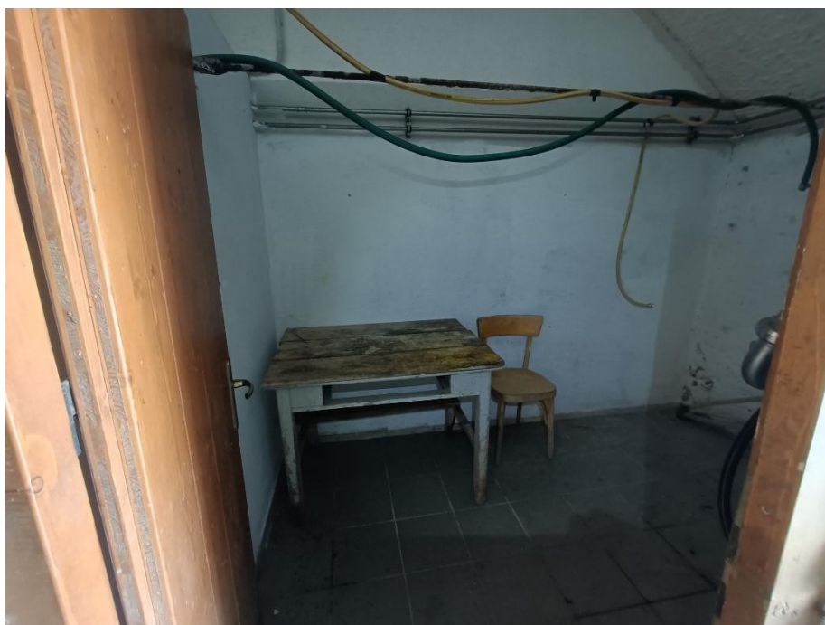
Foto 50 – STALLONE – LOCALE IMPIANTO DI LAVAGGIO MUNGITURA. Foto di data 29.10.2025
