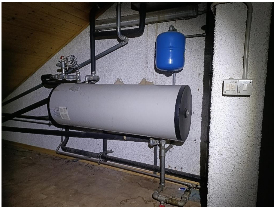
Foto 41 – MALGA TASSULLA – SOFFITTA – LOCALE DEPOSITO. Foto di data 29.10.2025
