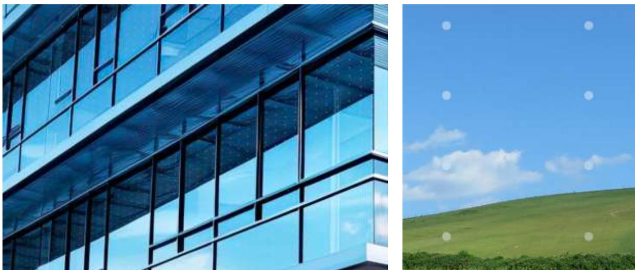
Figura 22. Sistemi di marcatura delle superfici vetrate (Costruire con vetro e luce rispettando gli uccelli - 2022, Stazione ornitologica svizzera di Sempach)
