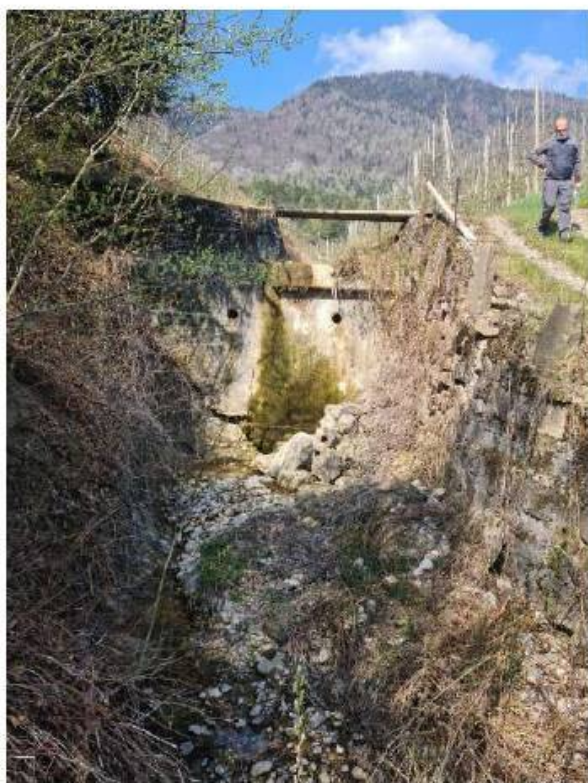
Briglia in c.a. esistente lungo il canale artificiale (Tratto 3)
