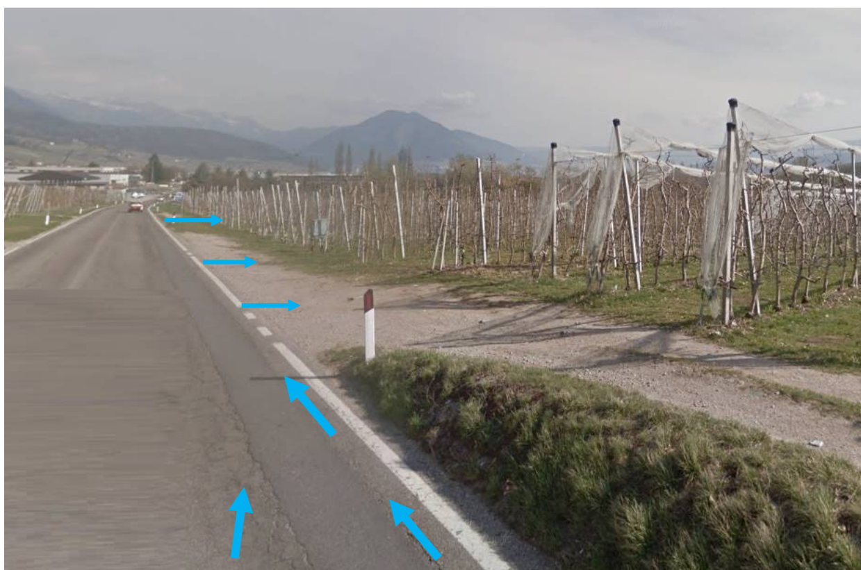
Foto 5: foto scattata lungo la S.P. 73 in direzione di Cles, all'altezza dell'area interessata dalla Variante al P.R.G. Le frecce azzurre indicano la possibile corrivazione idrica concentrata lungo la strada, in caso di tracimazione del rio Paglia a monte; l'acqua potrebbe riversarsi lateralmente alla strada, allagamento parzialmente l'area di studio.
